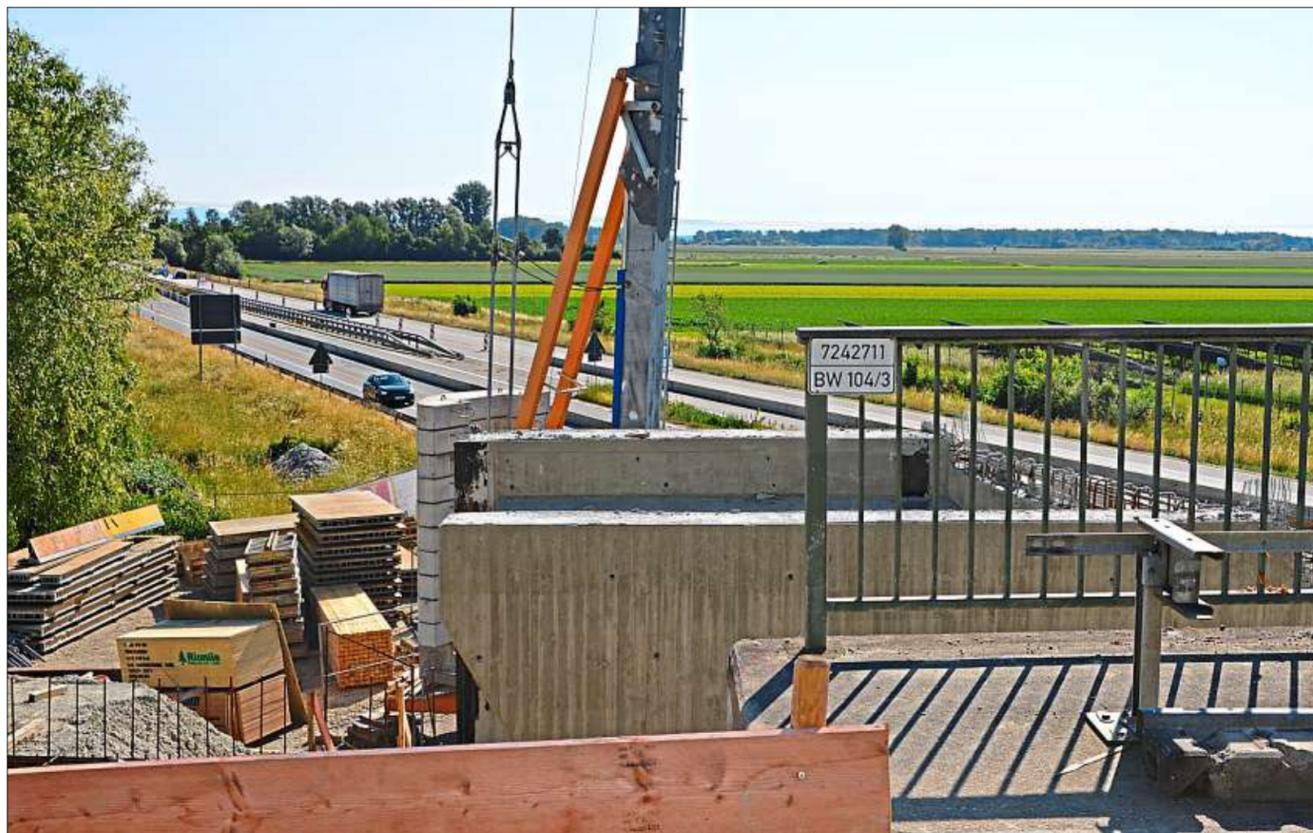
**Der Auflieger für die Radwegebrücke über die Autobahn ist bereit.** Dort wird Samstagnacht die neue Brücke gesetzt, dazu muss die Autobahn zwischen den Anschlussstellen Landau und Wallersdorf-West gesperrt werden. – Fotos: Nadler
